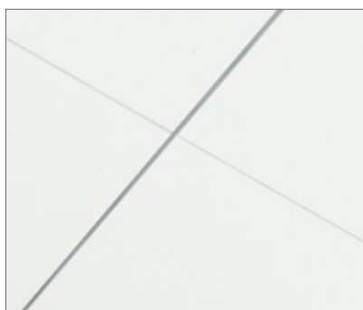
Прямая линия, созданная углублением системы в одном направлении, и цельный вид потолка в другом направлении.
